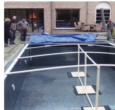
Die Konstruktion wird im Werk und nicht auf der Baustelle gefertigt. Unser Spezialtransporter bringt Ihren Pool hochkant oder quer gefahren an die Baustelle. Auch mehrteilige Becken sind möglich - Fügestellen werden dann vor Ort mit Mosaik überarbeitet.
