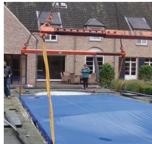
Die Konstruktion wird im Werk und nicht auf der Baustelle gefertigt. Unser Spezialtransporter bringt Ihren Pool hochkant oder quer gefahren an die Baustelle. Auch mehrteilige Becken sind möglich - Fügestellen werden dann vor Ort mit Mosaik überarbeitet.
