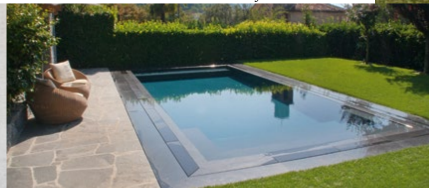
Freibad mit bauseits steinüberdeckter Überlaufrinne.
