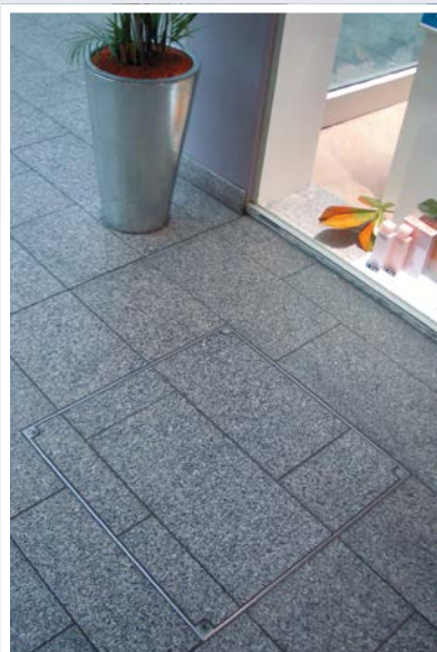
BV befüllt mit Granit
